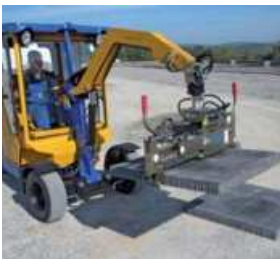
Hydraulische Versetzzange VZ-H-UNI
