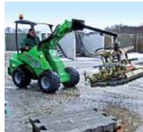
Hydraulische Verlegezange am Minilader
