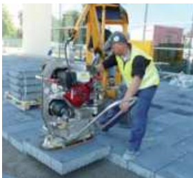
POWERJET PJ-1650-B Vakuumanbaugerät
