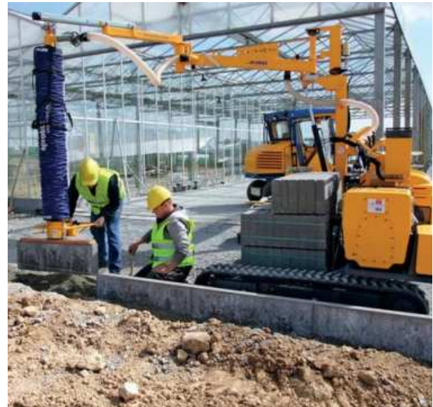
TRANSMOBIL TM Verlegetransporter bei der Bordsteinverlegung
