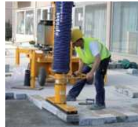
JUMBOMOBIL JM-VARIO Vakuum-Plattenverlegemaschine
