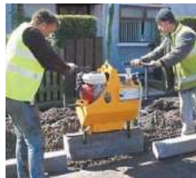
Vakuumanbaugerät SH-1000-MINI-B
