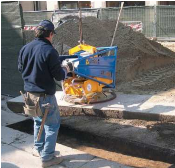
Vakuumanbaugerät SH-2500-UNI-B
