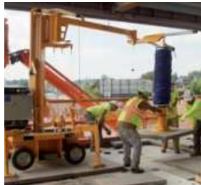
JUMBOMOBIL JM-VARIO Vakuum-Plattenverlegemaschine
