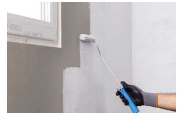
PCI Lastogum wird 2-lagig durch Rollen, Streichen oder Spachteln auf den Untergrund aufgebracht.
