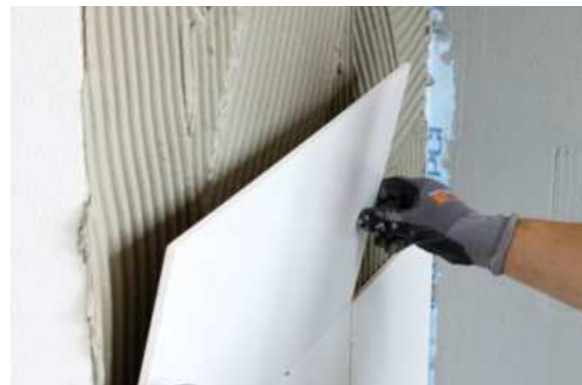
Mit PCI FT Extra können Steingutfliessen auf der alternativen Abdichtung PCI Lastogum sicher verlegt werden.
