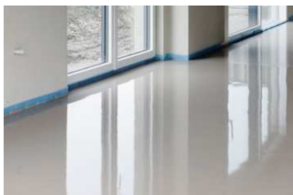
Entspanntes Arbeiten: Anrühren – Ausgießen – Läuft!
