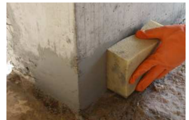
Der Feinspachtel PCI Barrafill L eignet sich insbesondere für vollflächige Kosmetikarbeiten an Betonbauteilen.
