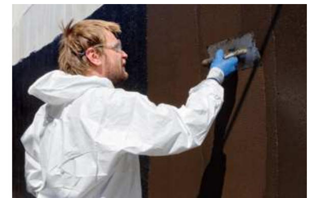
PCI Pecimor 2K eignet sich auch bei drückendem Wasser und aufstauendem Sickerwasser bis 3 m.
