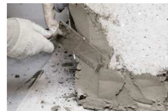
Der Instandsetzungsmörtel PCI Nanocret R4 PCC liefert sichere, hochfeste Ergebnisse bei der statischen Betonreparatur und setzt neue Maßstäbe in der komfortablen Verarbeitung.
