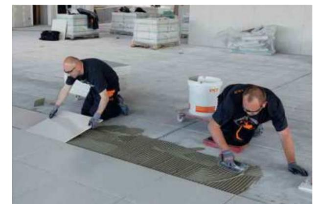
Mit dem hochverformungsfähigen PCI Flexmörtel® S2 können Fliesen und Platten bereits nach 3 Tagen belegt werden.
