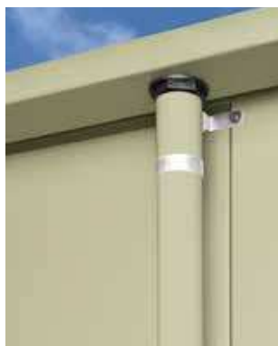
Regenfallrohr in RAL-Farbe des Hauses Ø 40 mm, Länge 1.936 mm
