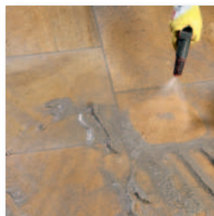
Einarbeiten mit Hartgummischieber und Wassersprühstrahl
