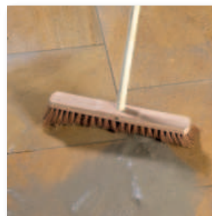
Entfernung letzter Mörtelreste mit Kokosbesen
