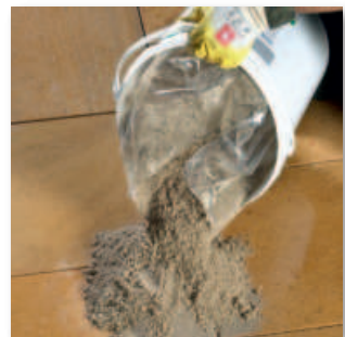
Portionsweises Aufbringen des Fugenmörtels
