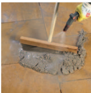
Einarbeiten mit Hartgummischieber und Wassersprühstrahl
