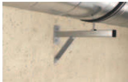
Lüftungsrohrbefestigung an der Wand
