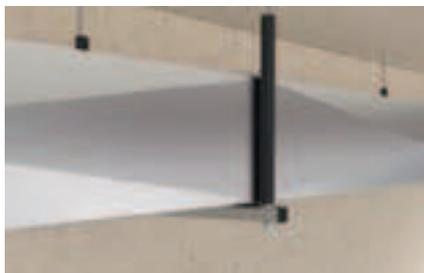
Lüftungskanalfestigung mit Montageschiene
