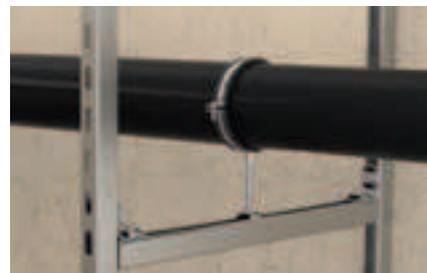
Rohrbefestigung auf Rahmenkonstruktion
